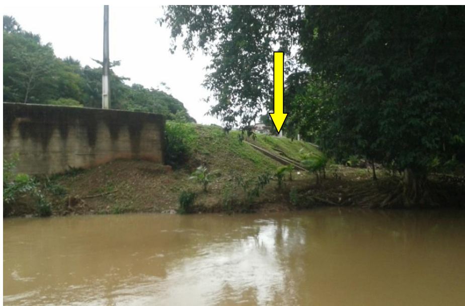
Figura 27 – Canaleta de escoamento pluvial na área urbana do Distrito do Apeú, Castanhal/PA
